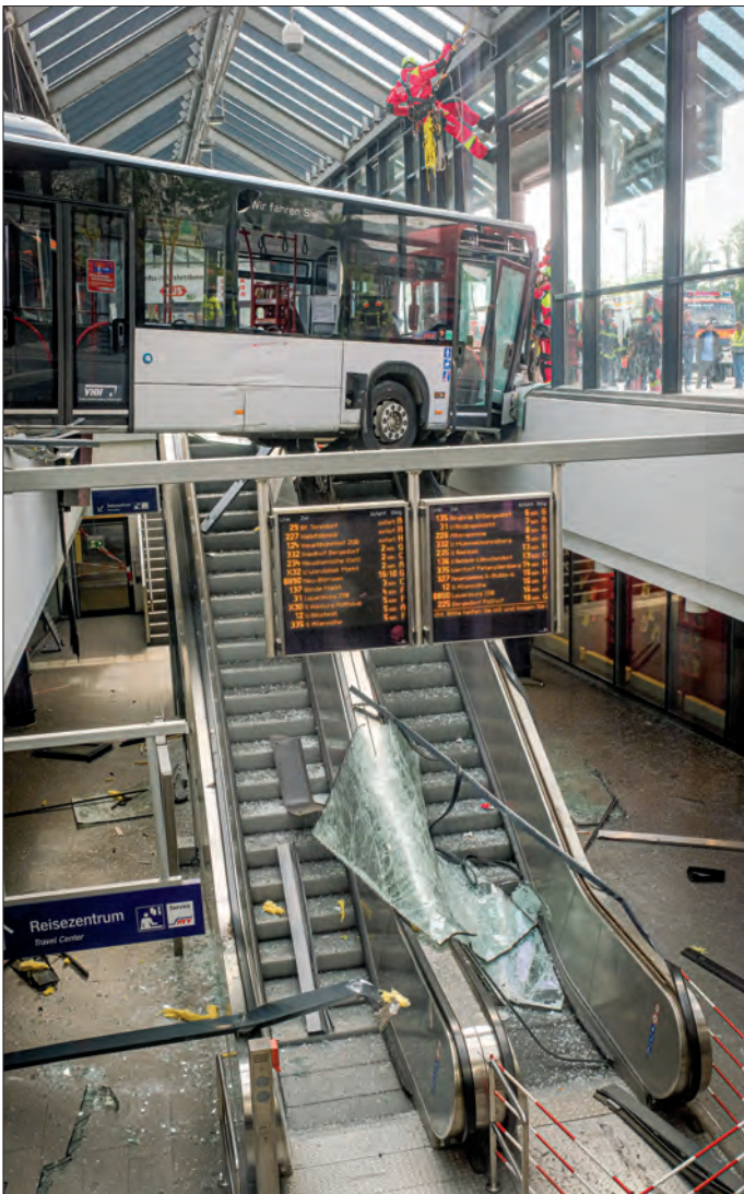
13.05.2020, THM, BERGEDORF: Unbesetzter Gelenkbus durchbricht Glasfassade des ZOB Bergedorf. Busfahrerin und ein Passant leicht verletzt. Sicherung des Busses und Bergung durch die SEG Höhenrettung sowie mittels Rüstwagen und Feuerwehrkrän in Zusammenarbeit mit einem Abschleppunternehmen
