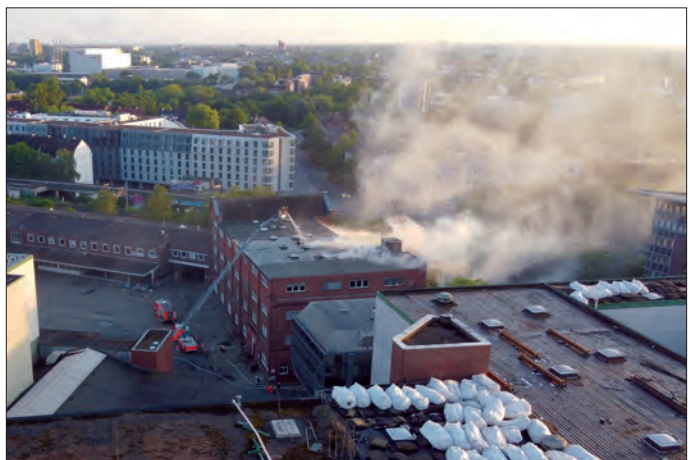
06.06.2020, FEU3, ALTONA: Ausgedehnter Dachstuhlbrand im vierten Stock eines leerstehenden Verwaltungsgebäudes auf circa 20 x 15 Meter. Brandbekämpfung über drei Wendehohr und vier C-Rohre im Innenangriff
