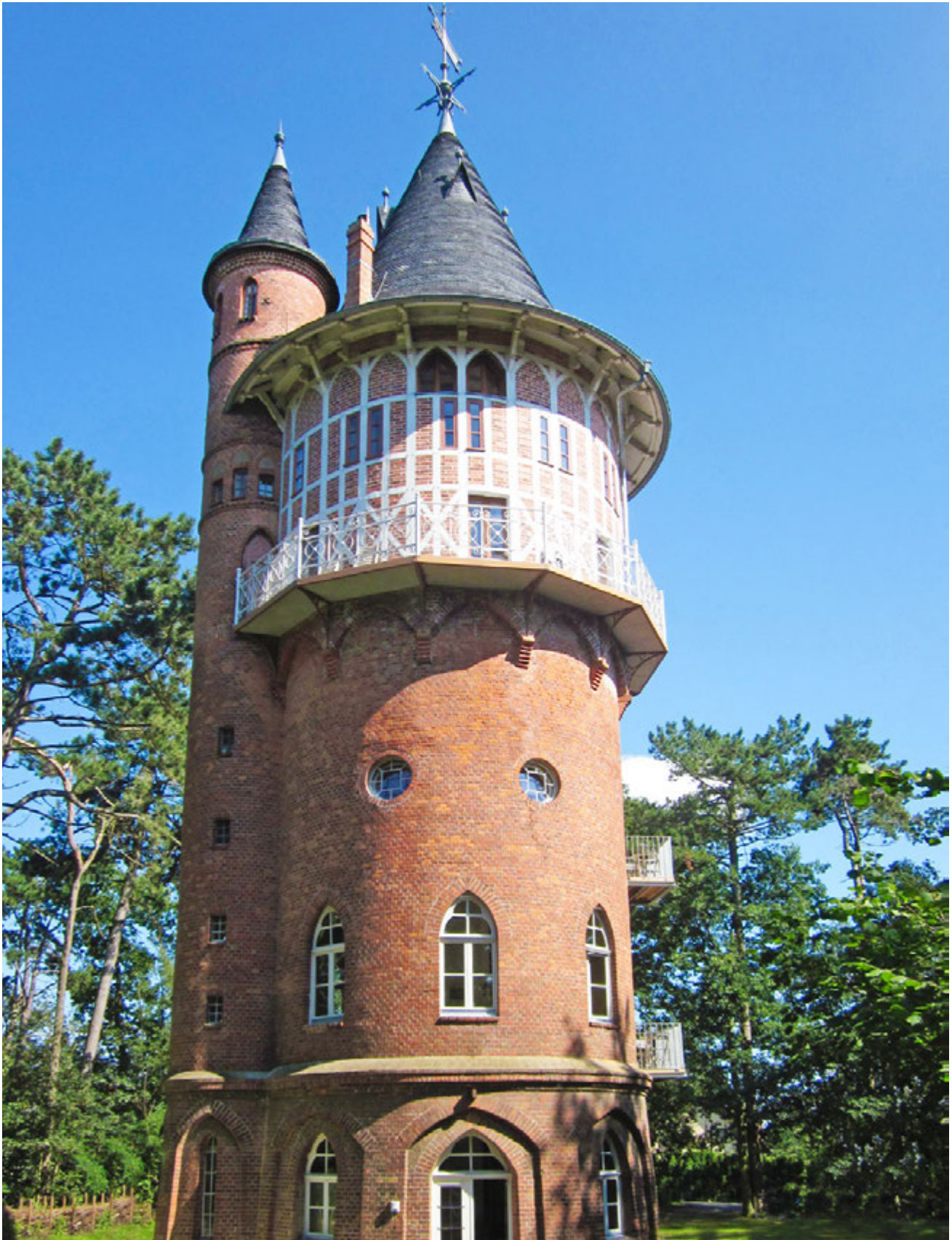
Der Wasserturm in Waren wurde durch die Genossenschaft aus seinem Dornröschenschlaf geholt.
