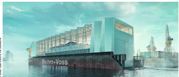
Überdachung der Blohm+Voss-Docks in Hamburg.
