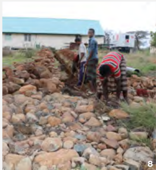
8 Mühsame Erdarbeiten im steinigen Klinikareal.
