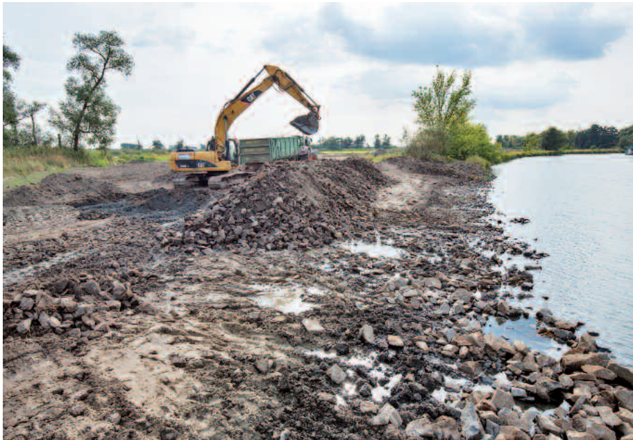
Baumaßnahme für den Gewässerschutz [K. Karkow]
