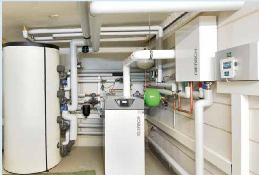
Hybridkomponenten I: 1.000-Liter-Pufferspeicher, (Giega-Therm), Öl-Brennwertgerät FCU 30-M und CTC-Steuerung im Heizraum.
