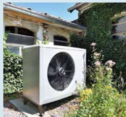
Hybridkomponente II: Die Luft-Wasser-Wärmepumpe Eco Air 520M ist im Außenbereich vor dem Heizraum platziert.
