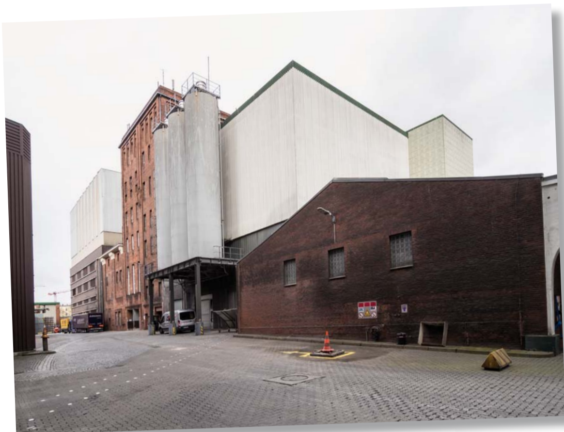
Der rote Klinkerturm soll erhalten werden, während industrielle Bauten verschwinden.
