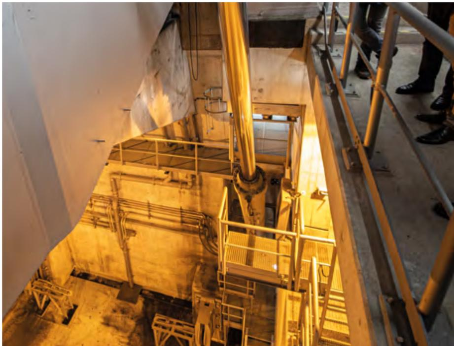
Ein verbogener Hydraulikzylinder stoppte die Retheklappbrücke
