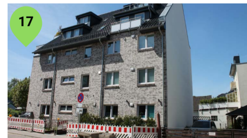
Wohnungsneubau Neuer Weg 50 Der Abbruch des Wohngebäudes wurde im Sommer 2016 durchgeführt. Die Fertigstellung des Neubaus mit 12 Wohnungen erfolgte im Jahr 2017.
