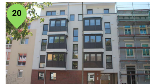
Wohnungsneubau Holtenklinker Str. 106 Das leerstehende Wohngebäude wurde abgebrochen und an dieser Stelle ein Neubau mit acht Wohnungen errichtet. Das Wohngebäude wurde in 2019 fertiggestellt.
