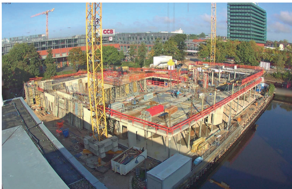
Baufortschritt am Körberhaus
