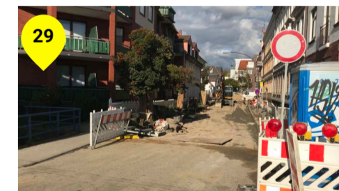
Umgestaltung Bleichertwiete Die Planung zur Umgestaltung des Straßenzugs wurde im Beirat Bergedorf-Süd präsentiert und diskutiert. Mit den Bautätigkeiten im Straßenbereich wurde Mitte September 2020 begonnen.
