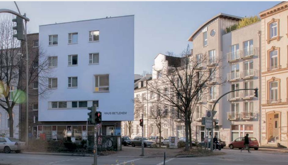
Die Fassade des Hauses an der Buderpester Straße, schräg gegenüber des St. Pauli Stadions. Foto: Birger Gente
