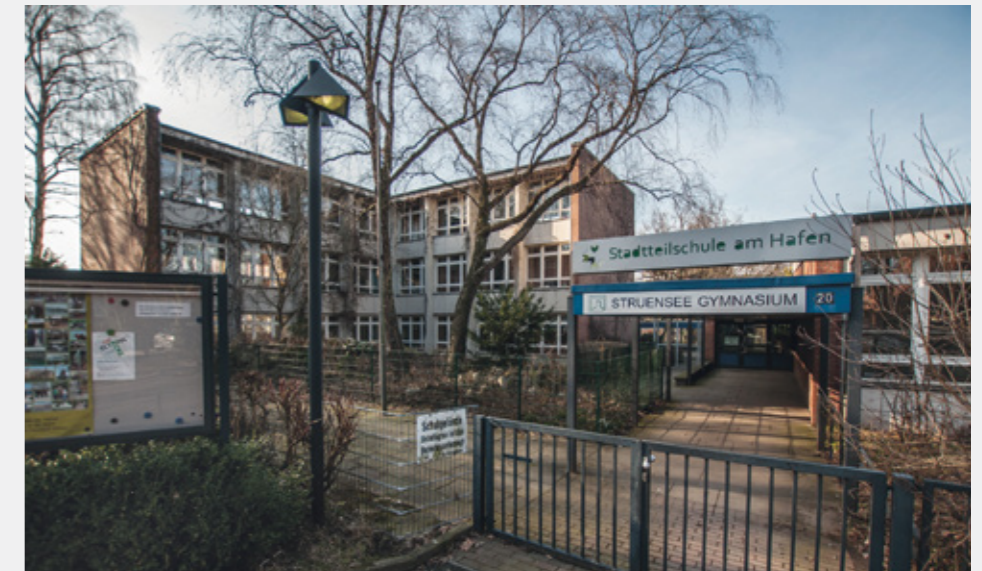
Bisherige Stadtteilschule Königstraße. Hier soll das dritte Gymnasium im Kerngebiet entstehen, wobei gleichzeitig die Raumkapazitäten am Standort Allee durch Baumaßnahmen ausgeweitet werden. Foto: Birger Gente
