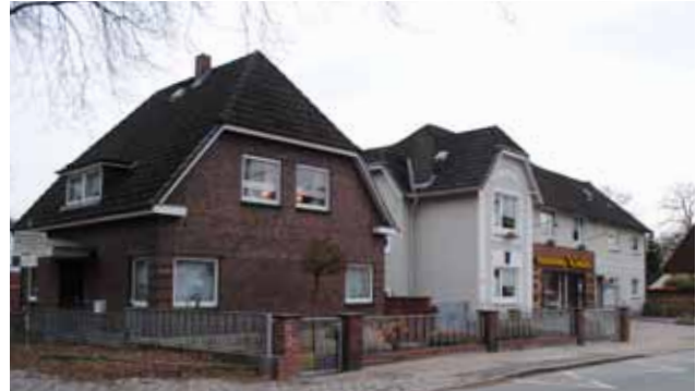
134 Umgebung mit teils dörflichen Strukturen (Alte Sülldorfer Landstraße)
