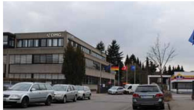
107 Büro- und Verwaltungsgebäude am Stich der Elbgaustraße
