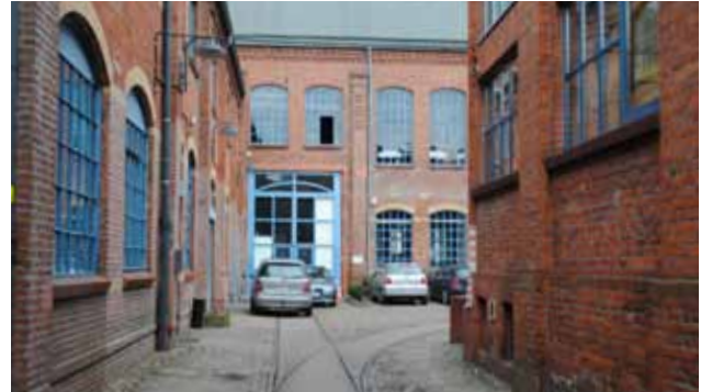
68 Umnutzung in Ottensen – früher Fabrik, heute Gewerbehof (Völckerstraße)
