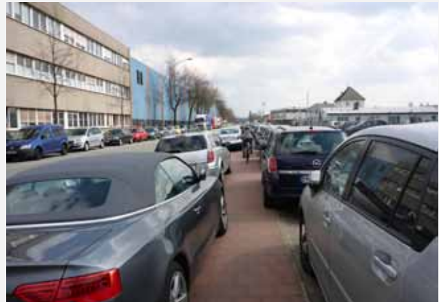
42 Die Liebigstraße vor der Sanierung
