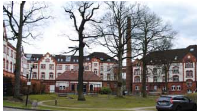
98 Historische Bestandsgebäude des Westend Village (Theodorstraße)
