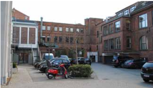
91 Historische Bausubstanz schafft Qualität und Atmosphäre (Gasstraße)
