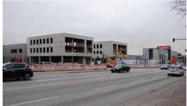
86 Neubau des Gewerbeparks Bahrenfeld (Schnackenburgallee)
