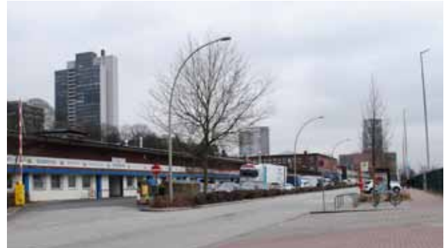
128 Lagerhallen von Fisch- und Feinkosthandel (Van-der-Smissen-Straße)
