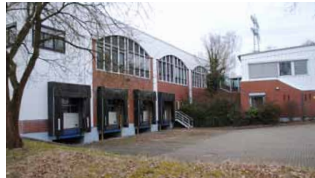
131 Standort des künftigen Handwerkerhofs (Alte Sülldorfer Landstraße)
