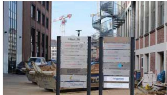
71 Wegweiser als Orientierungshilfe in den Gewerbehöfen
