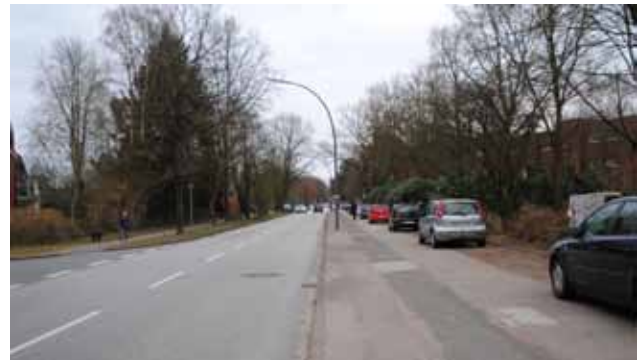
135 Frequentierte Straße mit Modernisierungsbedarf (Rissener Landstraße)
