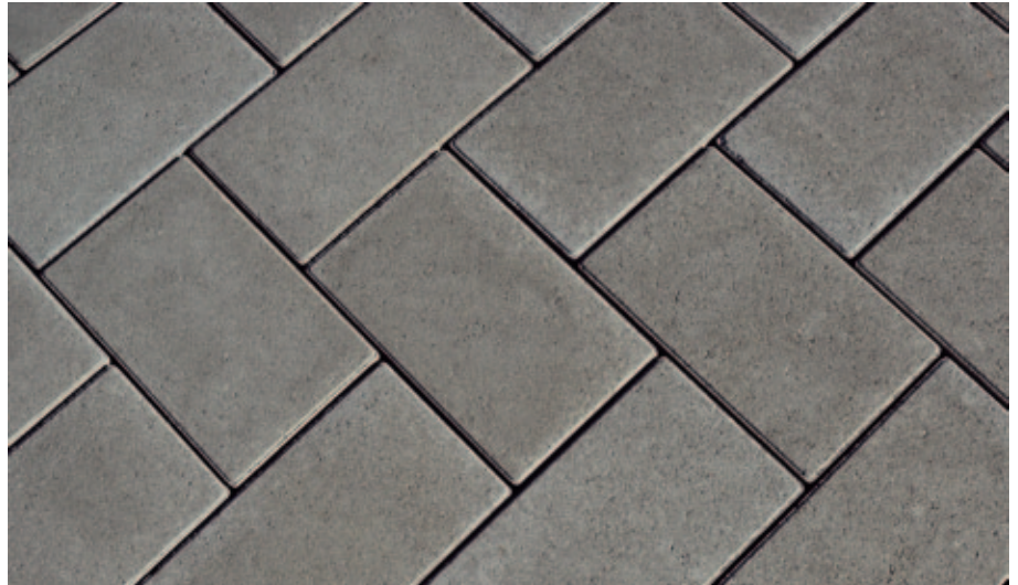
Im verlegten Zustand ist das werkseitig fixierte, steinumfassende EPDM Profil kaum zu erkennen.
