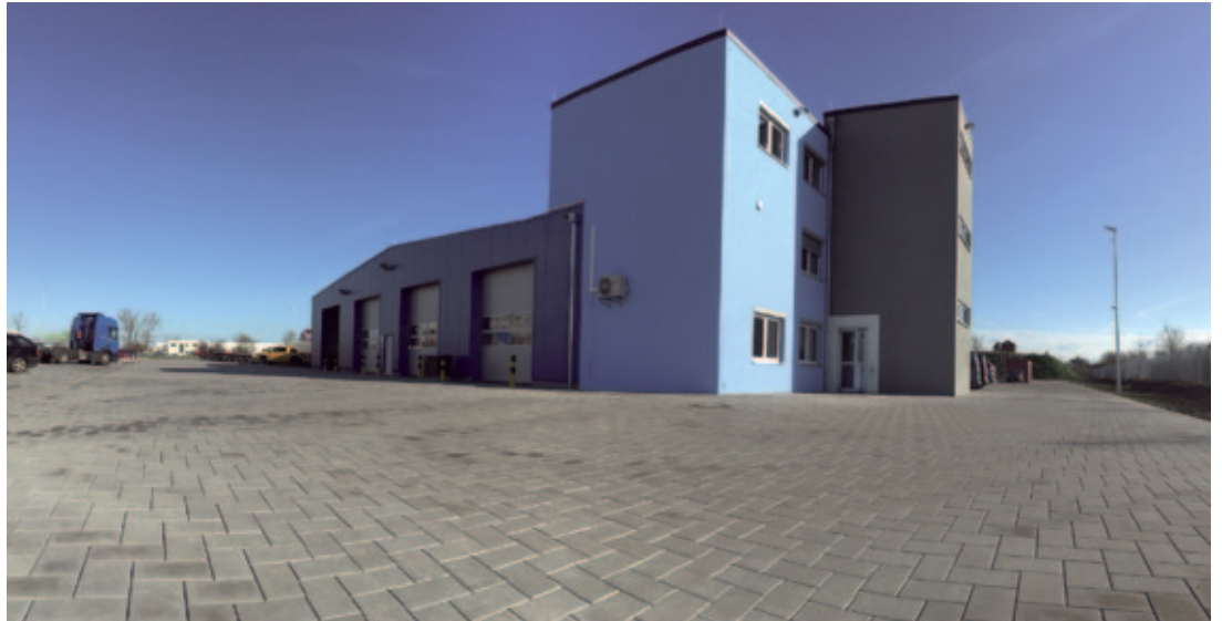
Das Pflastersystem COMBICONNECT wurde auch vor der Werkstatthalle im Format 30 x 18 x 10 cm im Ellenbogenverband im Farbton grau eingebaut. (Fotos: Beton-Pfenning)
