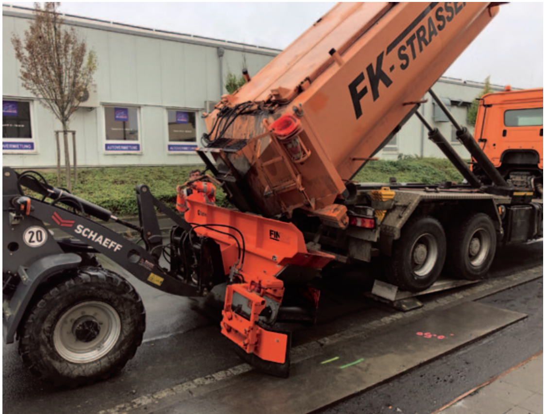
Die Material-Verteilschaukel „Finliner“ von Optimas kann direkt vom Lkw beladen werden und dies, falls erforderlich, auch mit Asphalt. (Foto: Optimas GmbH)
