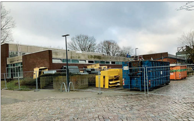
Die Entkernung der alten Schwimmhalle der HSU hat bereits begonnen. Foto: HSU
