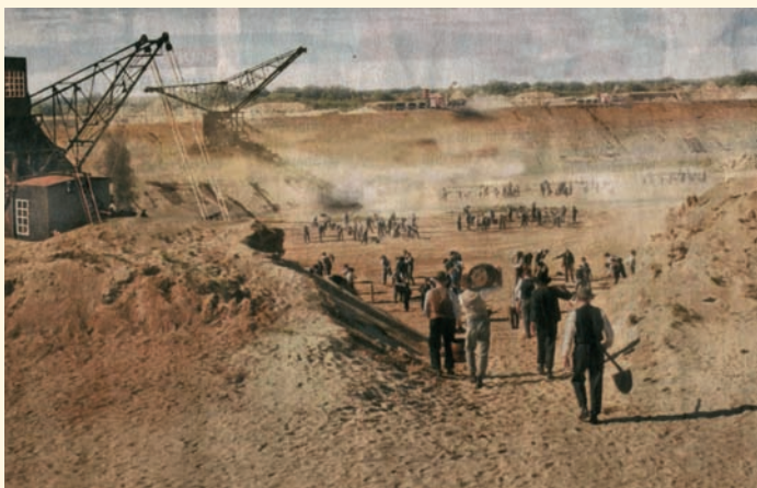
Baggerarbeiten im Kanalbett
