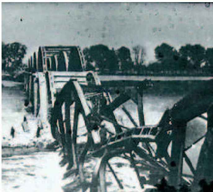
zerstörte Brücke über die Elbe
