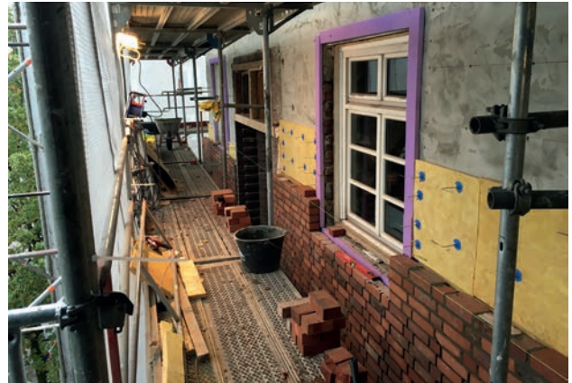
Fassadensanierung Reichardtblock: An der Bahrenfelder Chaussee mussten Teile der Fassade neu aufgemauert werden.
