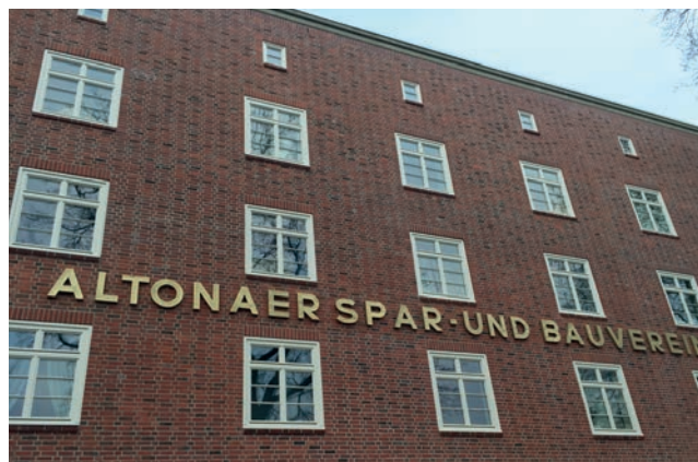
Wiederhergestellte Fassade an der Bahrenfelder Chaussee
