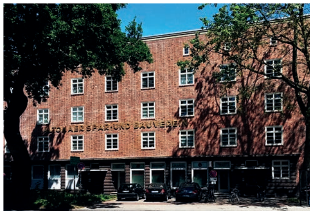
Die Fassade an der Bahrenfelder Chaussee nach der Sanierung
