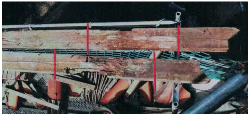
Kirchturm, schadhafte Balken im Auflagerbereich der Außenwand; Fotos: Volker Hauth
