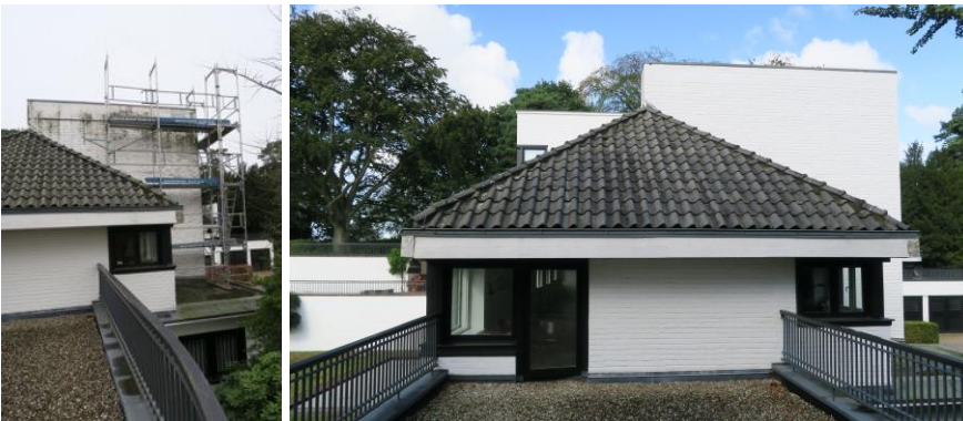
Fassade während und nach der Sanierung; Fotos: Elke Dröscher
