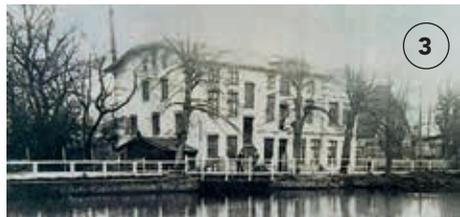
Auf dem Foto sehen Sie die Mühle mit dem Mühlenteich. Die Wandse fließt durch den Teich und trieb lange die Mühle an. Anfang der 1920er Jahre musste wegen Wassermangels auf elektro-Antrieb umgestellt werden.
