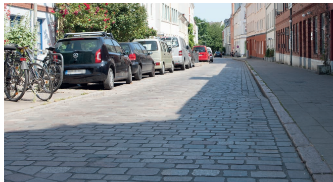
Strassenbelag in der Altonaer ZeiBstraBe
