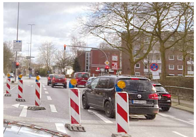
Ein bekannter Anblick: Baustellen. Über die Koordination in den Stadtteilen wird immer wieder Kritik laut.
