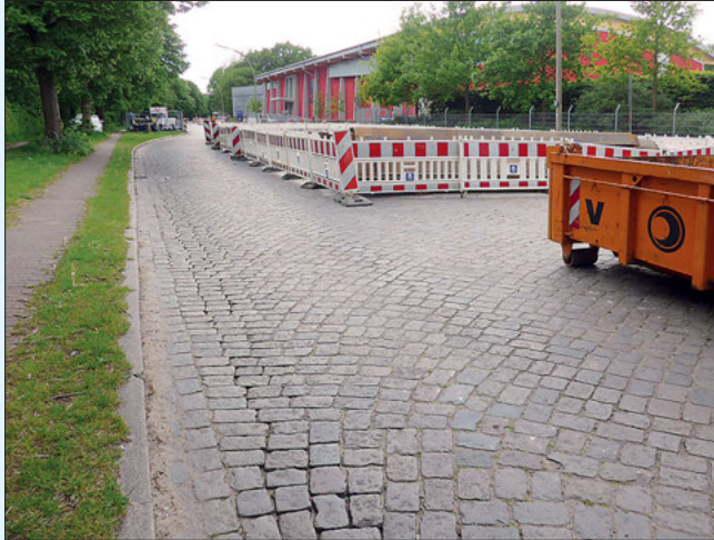
Am nördlichen Ende des Eulenkamps haben die Bauarbeiten bereits begonnen. Im Hintergrund die markante Halle und Sitz des Hamburger Handball-Verbands. Fotos: Thorsten Richter
