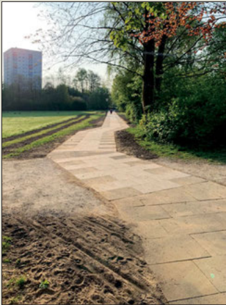
Der stark genutzte Schulweg wurde Grund instandgesetzt.
