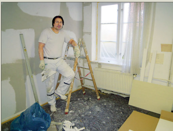
Michael Stojanowski sanierte die feuchte West-Wand im Heimatmuseum von außen und innen. Foto: Thorsten Richter
