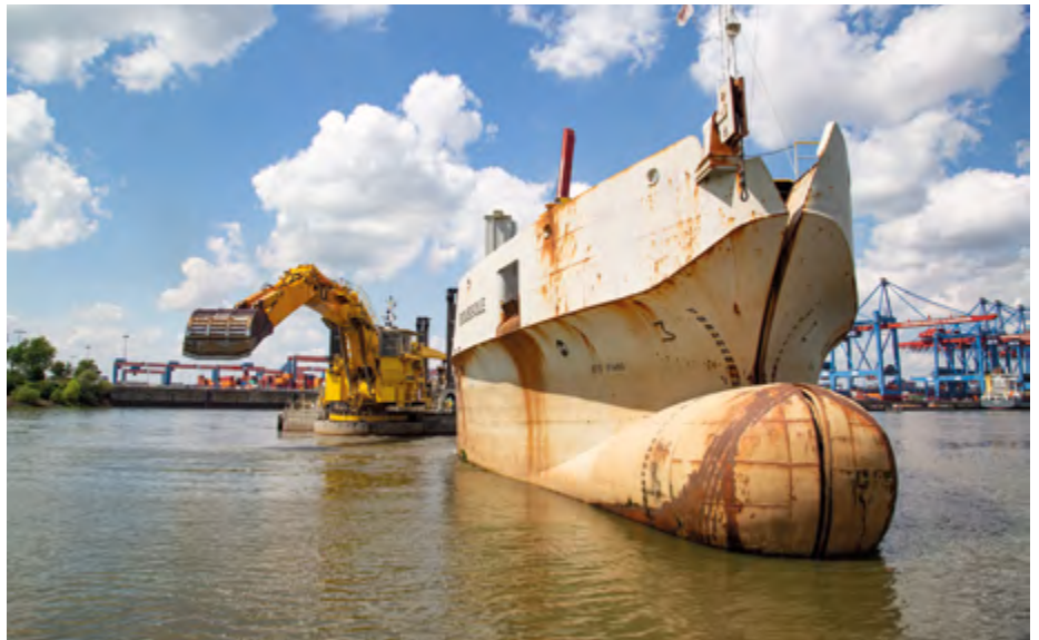
28 Tonnen Aushub mit einer Schaufel fallen in das Transportschiff
