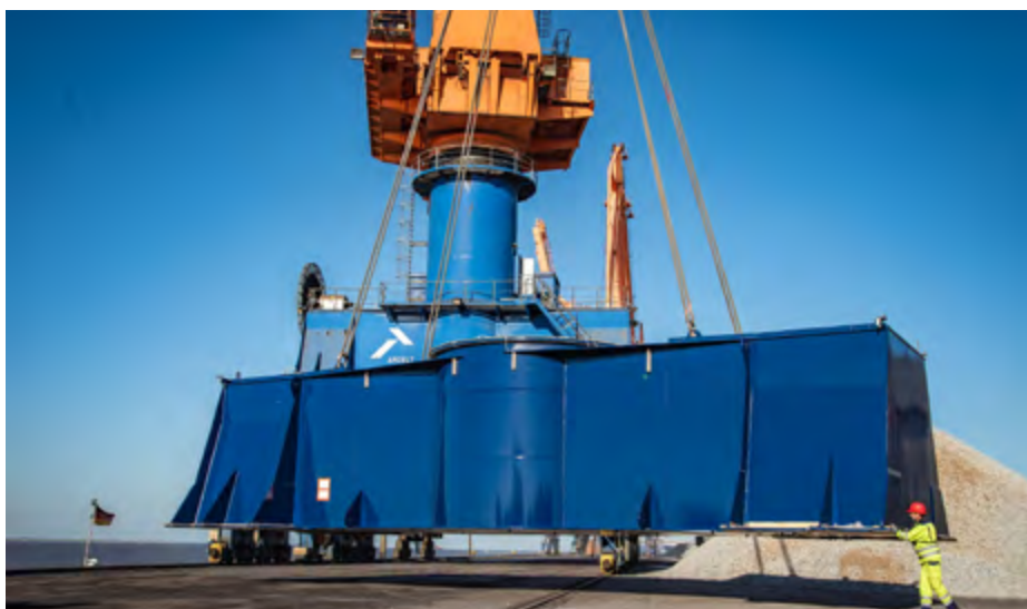
Der Querriegel wird in Position gebracht
