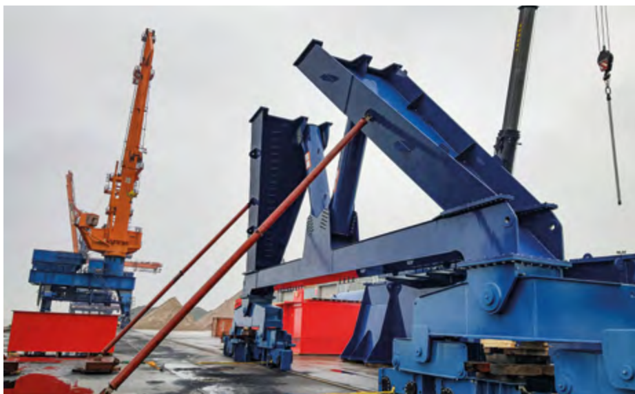
Das erste Fahrwerk steht auf den Kranschiene
