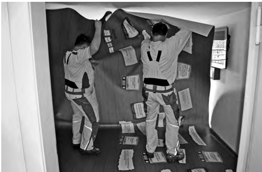
Während der Verlegearbeiten
