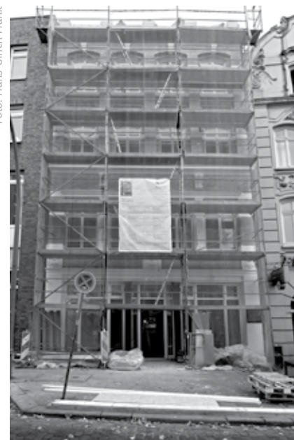
Das Haus der BürgerStiftung Hamburg im Baugerüst.
