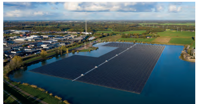
Das Floating-PV-Projekt Sekdoorn nahe der niederländischen Stadt Zwolle kommt auf eine Gesamtleistung von 14,5 MWp.
