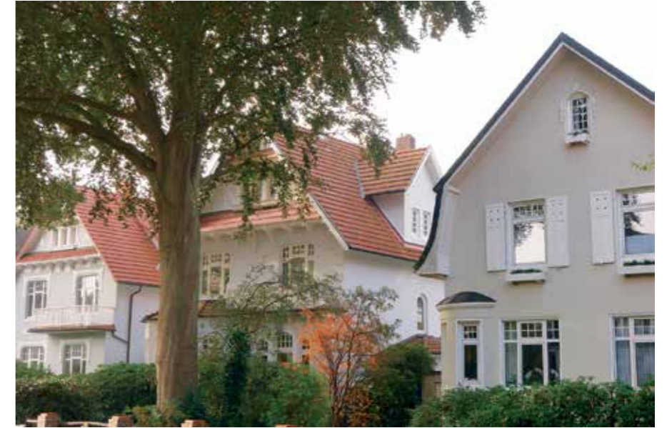
In der Remstedtstraße stehen die Häuser 4-10 unter Denkmalschutz; die Abbildung zeigt die Häuser 6-10; das Haus Nr. 6 (rechts) wurde 1909 von August Nissen entworfen
