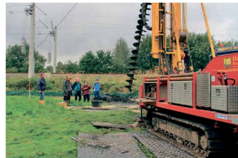
Ahrensburg «Querung Brauner Hirsch»: Mit schwerem Bohrgerät werden altsteinzeitliche Kulturreste aus bis zu 8 m Tiefe aus dem verlandeten Seebecken geborgen. Für die Mitarbeiter der Harms Brunnenbau GmbH aus Cuxhaven und die beteiligten Archäologen war dies ein ungewöhnlicher und besonders spannender Geländeeinsatz (Ahrensburg LA 189).
