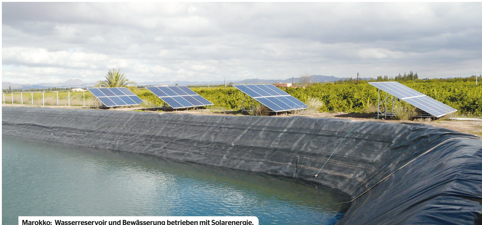
Marokko: Wasserreservoir und Bewässerung betrieben mit Solarenergie.
