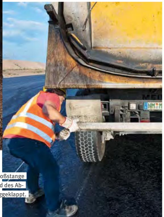
Die Heckstoßstange ist während des Abladens weggeklappt.
