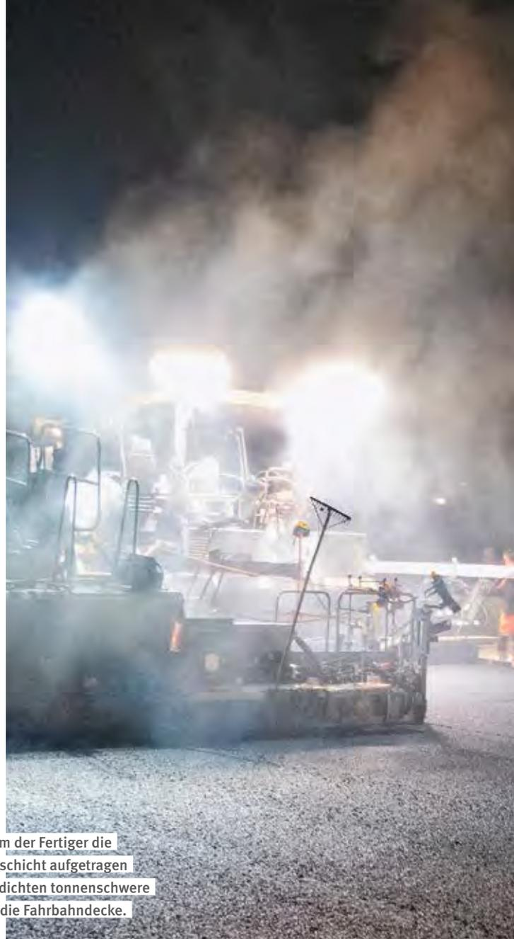
Nachdem der Fertiger die Asphaltdecke aufgetragen hat, verdichten tonnenschwere Walzen die Fahrbahndecke.
