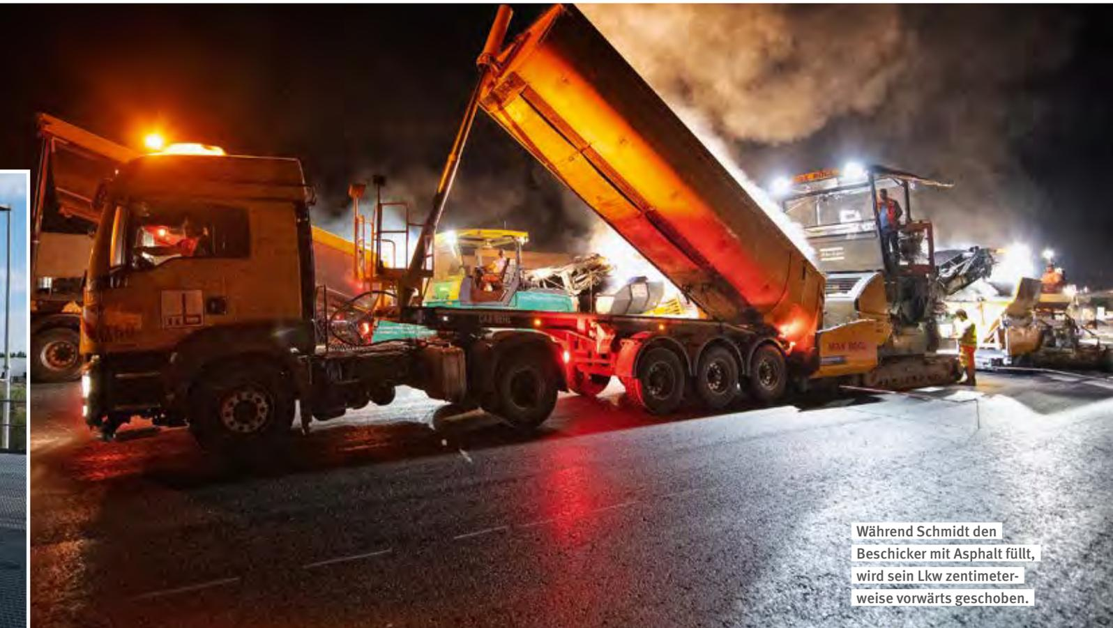
Während Schmidt den Beschicker mit Asphalt füllt, wird sein Lkw zentimeterweise vorwärts geschoben.
