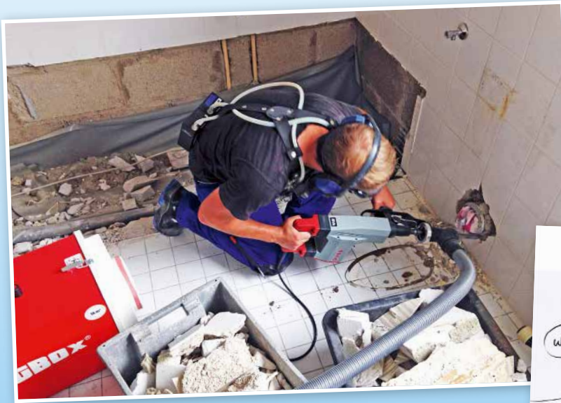
Staubarmes Entfernen asbesthaltigen Fliesenklebers
