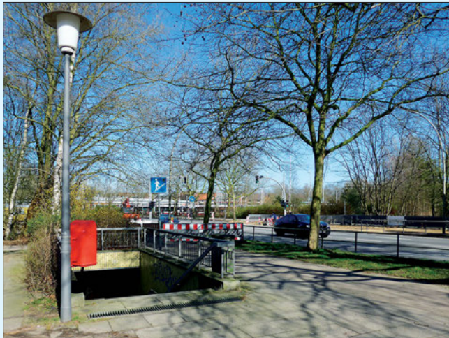
Der Fußgängertunnel unter dem Ring 2 in Höhe des Grünzugs an der Wandse ist nicht barrierefrei und für Radfahrer ungeeignet. Er dient als Zugang zum Notausstieg aus dem U-Bahn-Tunnel. Im Hintergrund die neue Ampelanlage. Fotos: Thorsten Richter
