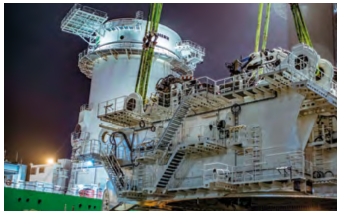
Das Kernstück ist das Maschinenhaus
