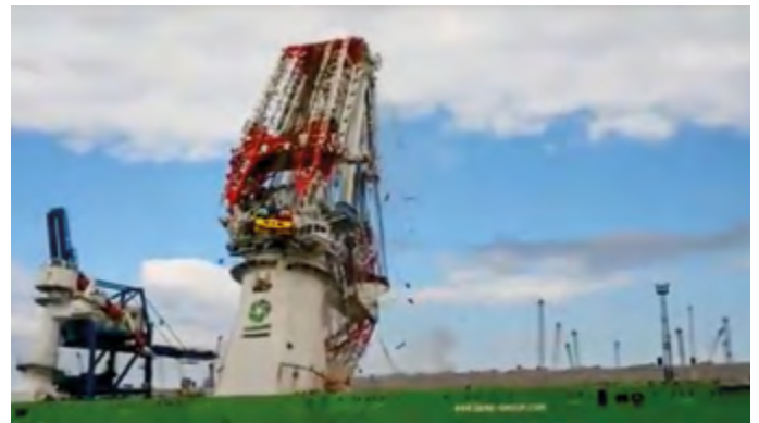
Teile fliegen in alle Richtungen, verletzen Arbeiter
