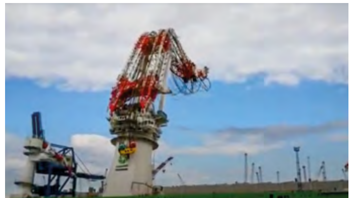
Oberhalb des A-Blocks knickt der Ausleger ab
