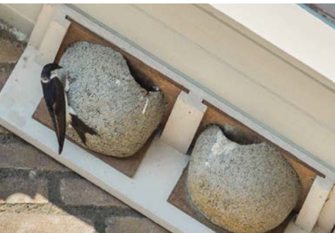
Mehlschwalbennisthilfen auch an der Dachschräge
