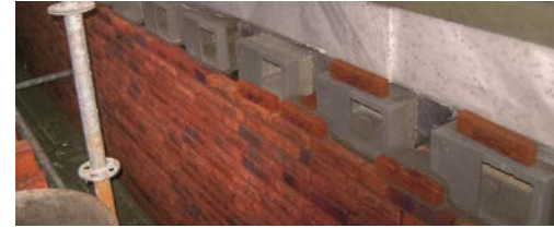
Einbau Mauerseglernisthilfen
