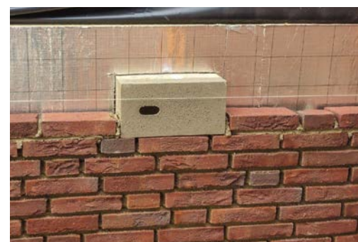
Mauerseglernisthilfe einbauen
