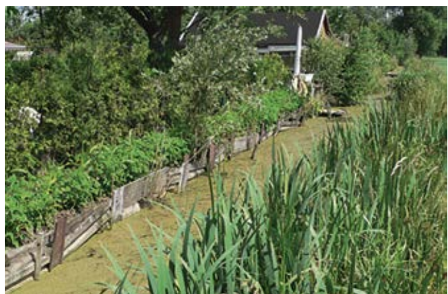
Abbildung 46: Uferverbau in Bergedorf (IB)
