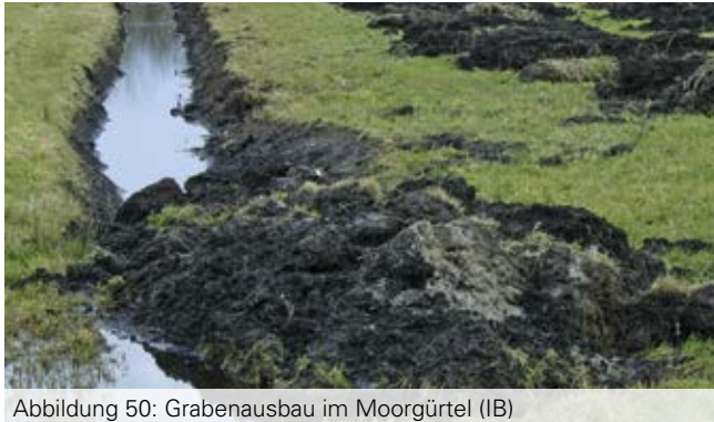
Abbildung 50: Grabenausbau im Moorgürtel (IB)
