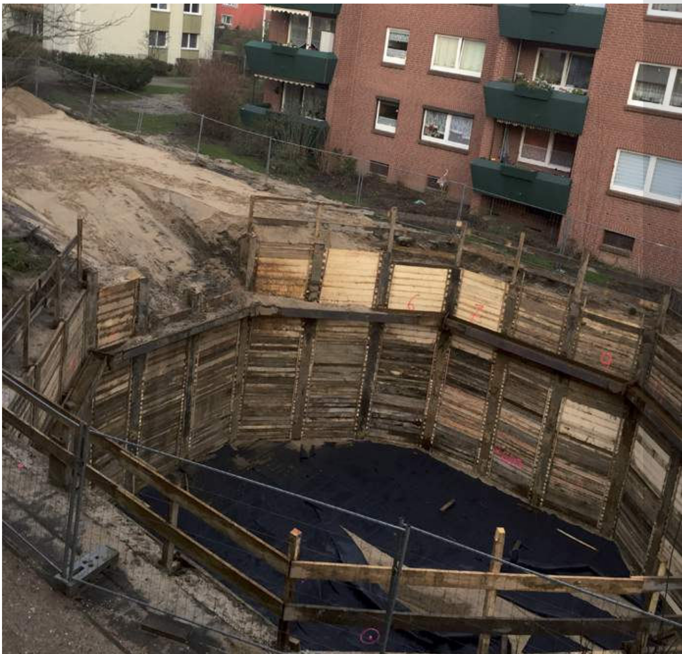
Baugrube für den Eisspeicher Reeseberg 177 a-c
