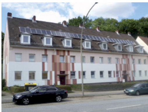
Winsener Straße 84 a + b - Fassadenanstrich
