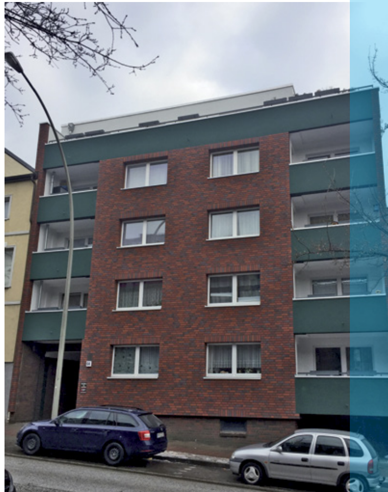
Schwarzenbergstraße 64 mit Wärmedämmverbundsystem
