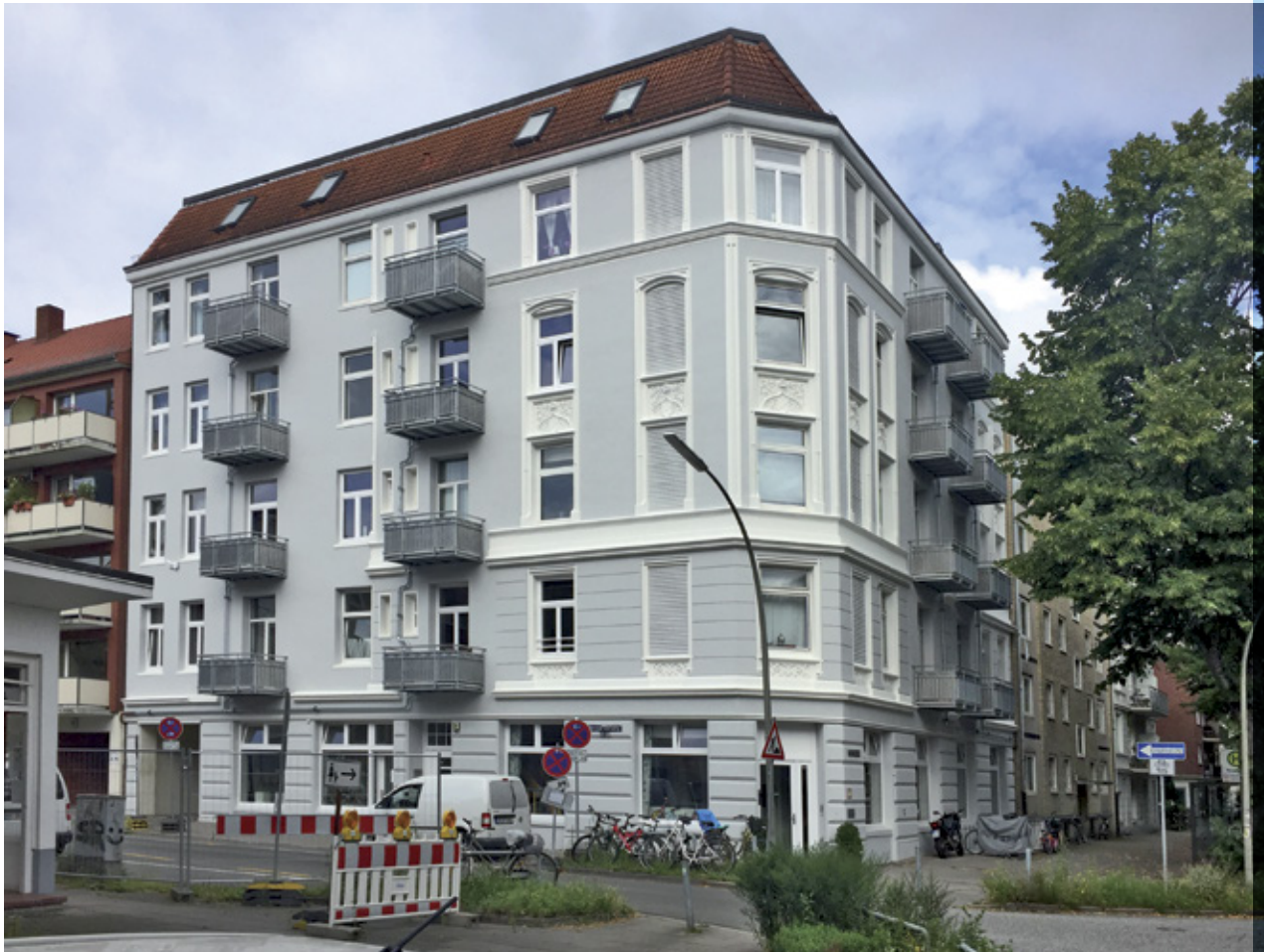
Mozartstraße 35 - Fassadensanierung und Balkonerneuerung
