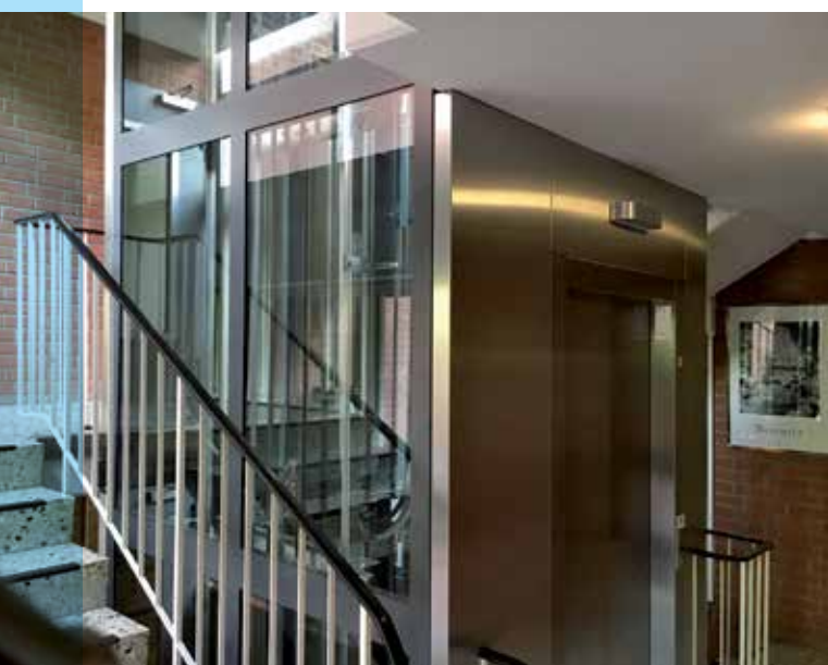
Aufzugseinbau Reeseberg 175 a
