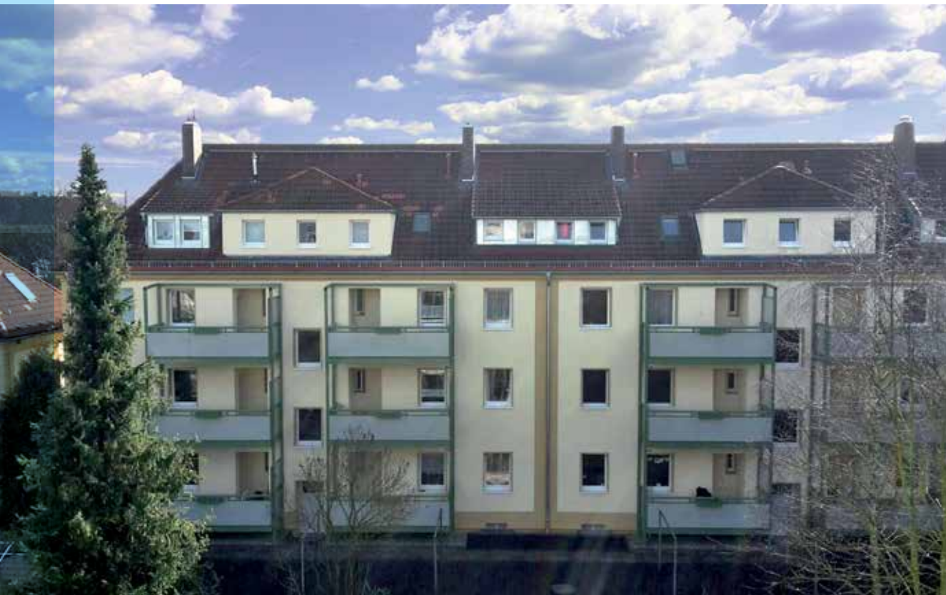
Zimmermannstraße 3 - 5, Wärmedämmverbundsystem und Balkonanbau
