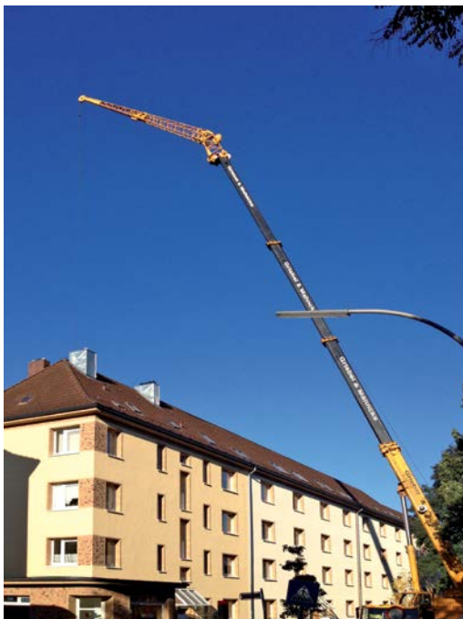
Reeseberg 22-28 jetzt wärmegeklämmt – zusätzliche Balkone kommen per Telekran
