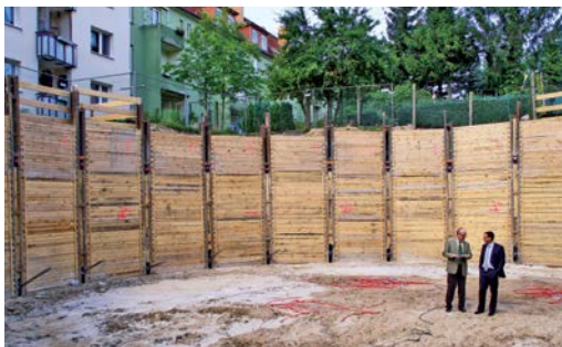
Der „Eisspeicher“ noch als Baugrube
