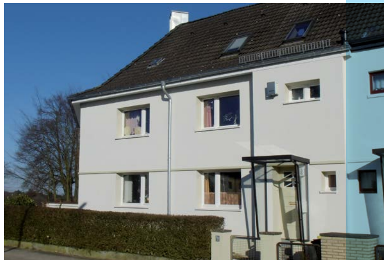
Max-Halbe-Str. 36/38 jetzt mit Wärmedämmverbundsystem
