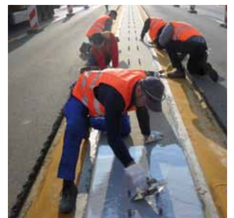
Hauptsache dicht: Feuchtigkeit ist die Ursache für nahezu alle Schäden.
