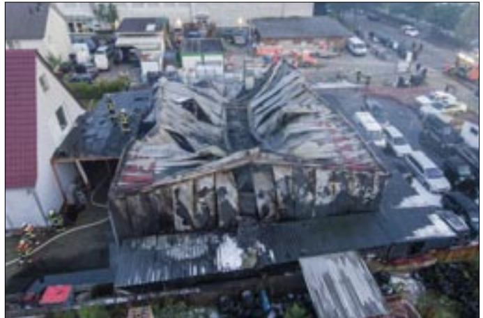
01.08.2019, FEU3, Wilhelmsburg: Kfz-Werkstatt brennt auf rund 25 x 16 Metern in voller Ausdehnung, Ausbreitung auf Wohngebäude und Reifenstapel durch Riegelstellungen verhindert. Massive Brandbekämpfung mit neun C-Rohren und einem Wenderohr über Drehleiter
