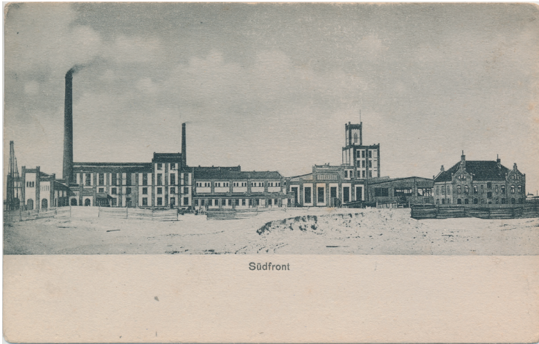
Hoch- und Tiefbaufirma H. C. Hagemann, 1911. Foto: © AMH
