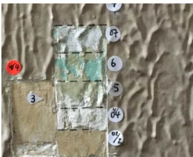
Bild 04: Detail Befunduntersuchung Zentraler Block, Jean-Paul-Weg, 2018
