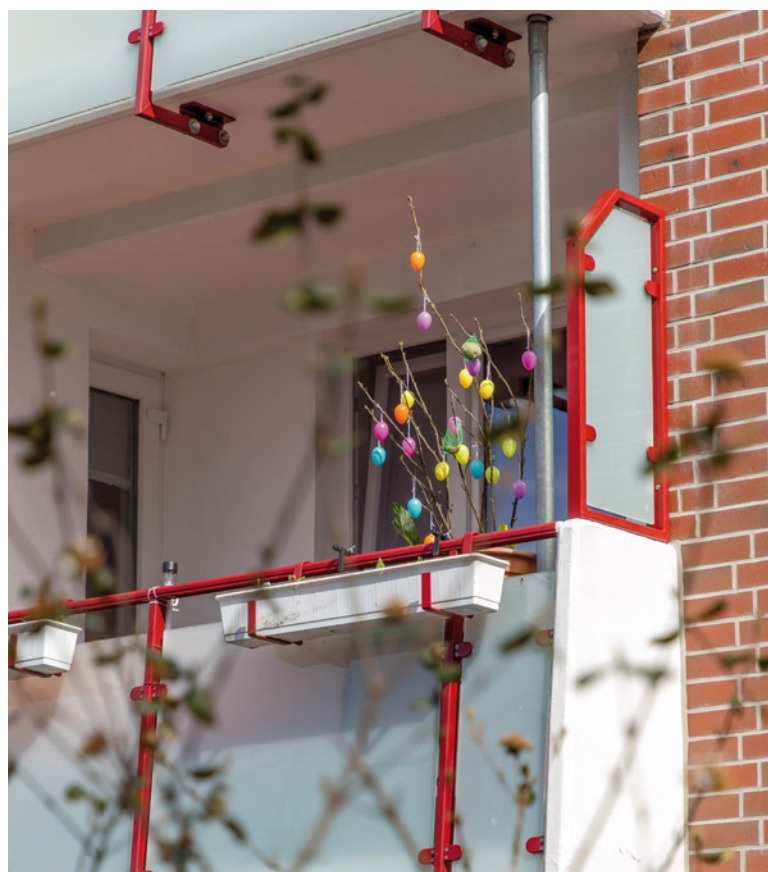
VE 16: Modernisierte Häuser und Außenbereiche in Sasel links: Fassadenausschnitt mit Loggia rechts: Ein Ergebnis des Außenanlagen-Workshops mit unseren Mitgliedern – das Sudoku-Feld bei Lüttmelland 3
