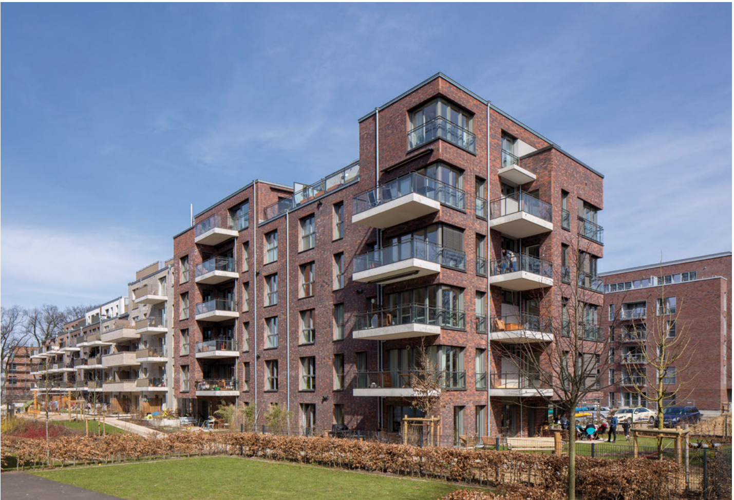
VE 83: Neubau von 41 öffentlich geförderten Wohnungen mit der Baugemeinschaft „Vier für Finkenau“ in der Leo-Leistikow-Allee, Uhlenhorst
