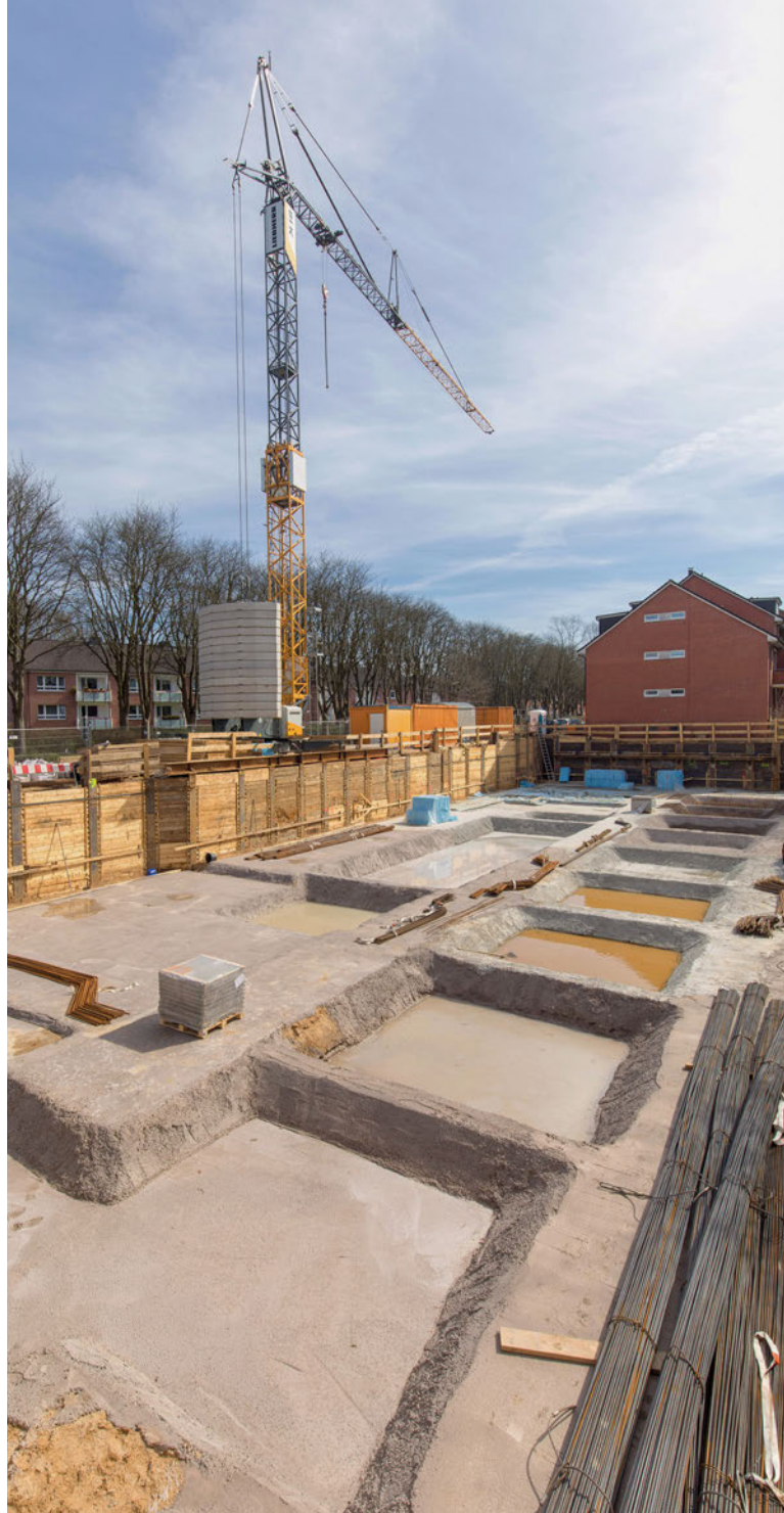
VE 87: Baugrube für eines der neuen Gebäude im Lüttmelland
