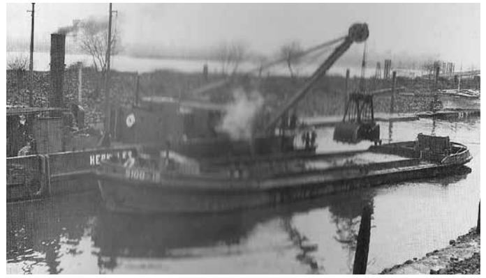
Ausbaggern des Hafens
