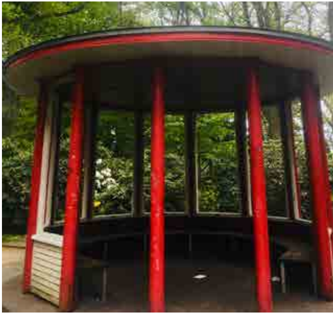
O'Swaldscher Pavillon, Endstation des Pilgerweges.
