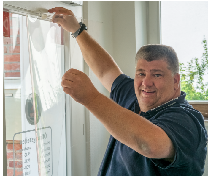
Sauber, schnell, maßgenau: die „unsichtbare Panzerfolie“ wird von Innen auf die Scheibe geklebt.
