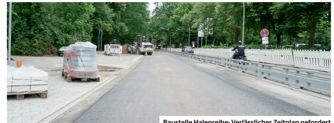
Baustelle Halenreihe: Verlässlicher Zeitplan gefordert
