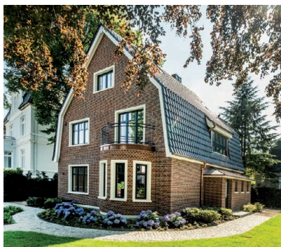
Eine Perle in neuem Glanz – saniert von Grell & Kröncke
