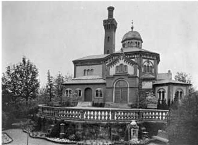
Altes Krematorium mit Urnengräbern, nach 1911. Foto: Denkmalschutzamt Hamburg.
