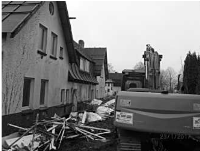
Abrissbagger am Maienweg Anfang 2018. Foto: Klaus Struck.
